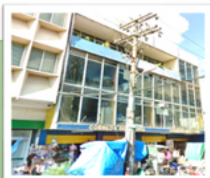
Ex Edificio de Correos SCZ
