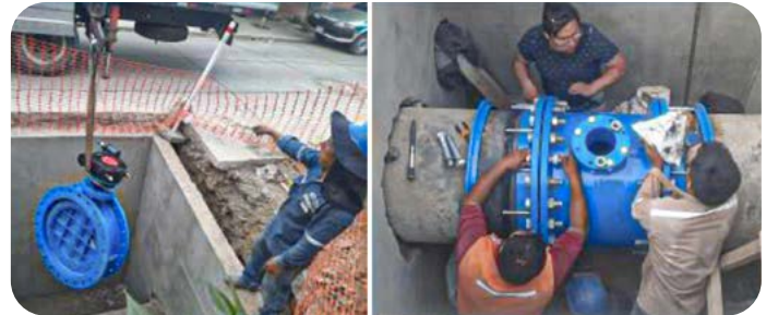
MMAyA: CONSTRUCCIÓN DEL SISTEMA DE AGUA POTABLE - SACABA
