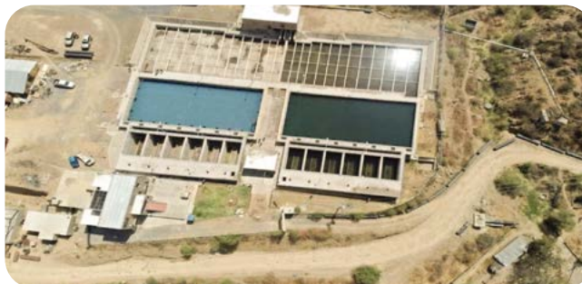
CONSTRUCCIÓN ADUCCIÓN 1 PLANTA DE TRATAMIENTO DE AGUA POTABLE JOVE RANCHO TIQUIPAYA - COCHABAMBA - SACABA Inversión: Bs278,4 millones*
