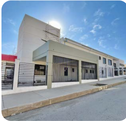
CONSTRUCCIÓN UNIDAD EDUCATIVA TERESA HINOJOSA CAPRIROLO DISTRITO 9 - COCHABAMBA
