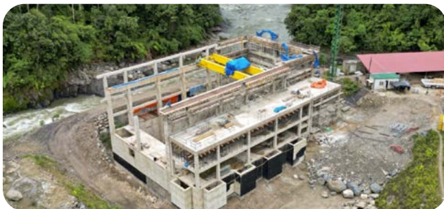
CONSTRUCCIÓN PLANTA DE GENERACIÓN HIDROELÉCTRICA IVIRIZU Inversión: Bs4.425,9 millones*
