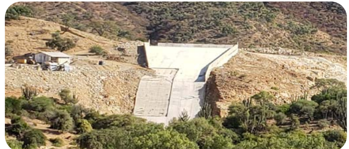
EMAGUA: CONSTRUCCIÓN DE LA REPRESA ANGOSTURA - OMEREQUE
