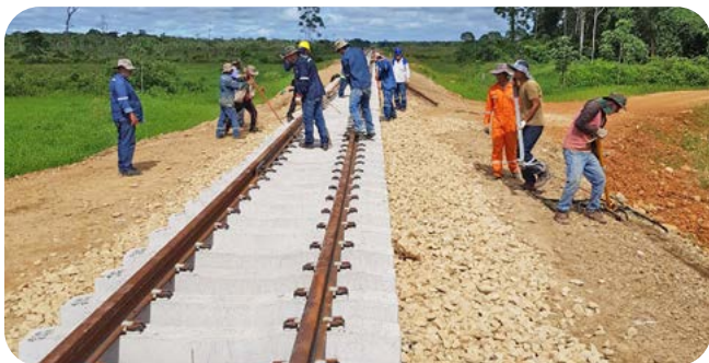
CONSTRUCCIÓN DE OBRAS VÍA FÉRREA BULO BULO - MONTERO** Inversión: Bs2.139,2 millones*
