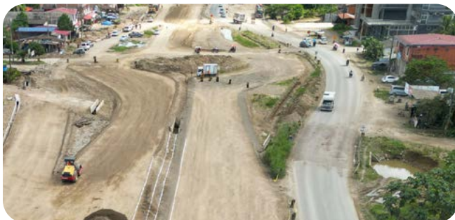
CONSTRUCCIÓN DOBLE VÍA VILLA TUNARI - PUENTE CHIMORÉ Inversión: Bs654,2 millones*
