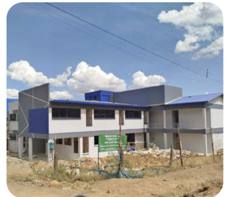
CONSTRUCCIÓN UNIDAD EDUCATIVA MARCELO QUIROGA SANTA CRUZ - ARBIETO
