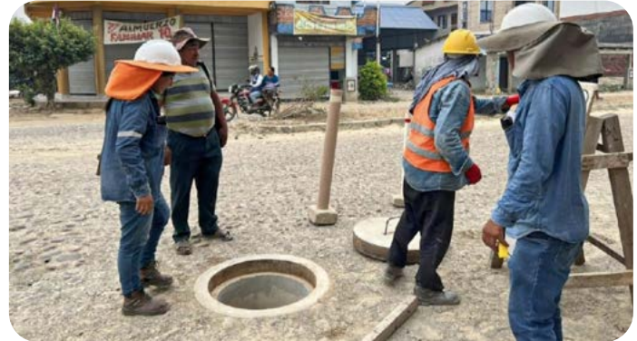
MMAyA: MEJORAMIENTO Y AMPLIACIÓN DEL SISTEMA DE ALCANTARILLADO SANITARIO - ENTRE RÍOS
