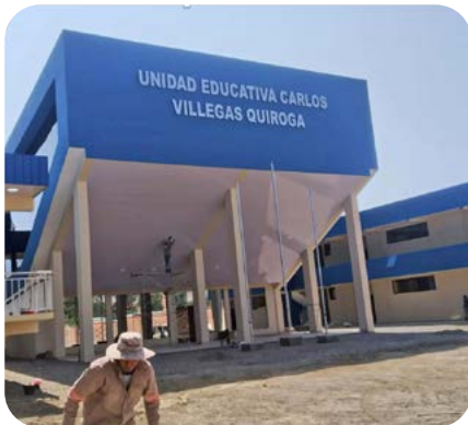
CONSTRUCCIÓN UNIDAD EDUCATIVA CARLOS VILLEGAS QUIROGA DISTRITO LAVAS LAVA - SACABA
