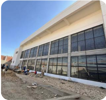
CONSTRUCCIÓN CENTRO DE SALUD INTEGRAL USHPA USHPA DISTRITO 8 - COCHABAMBA
