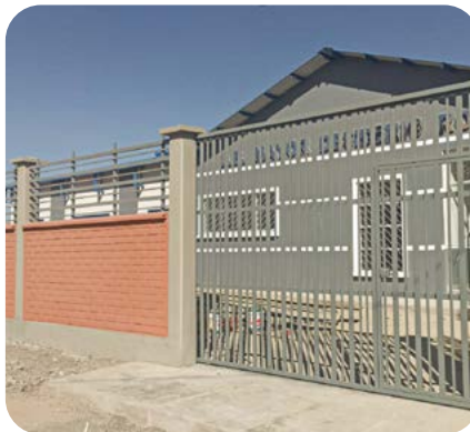
CONSTRUCCIÓN UNIDAD EDUCATIVA MAYOR DESIDERIO ROCHA - PUNATA
