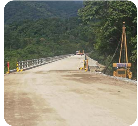
CONSTRUCCIÓN PUENTE VEHICULAR UNIÓN ESPÍRITU SANTO - CENTRAL UNIÓN ESPÍRITU SANTO - DISTRITO 10 - VILLA TUNARI
